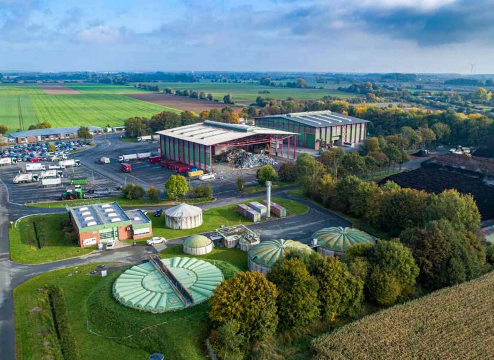
Das Abfallbehandlungszentrum mit Deponie in Wunstorf-Kolenfeld.
