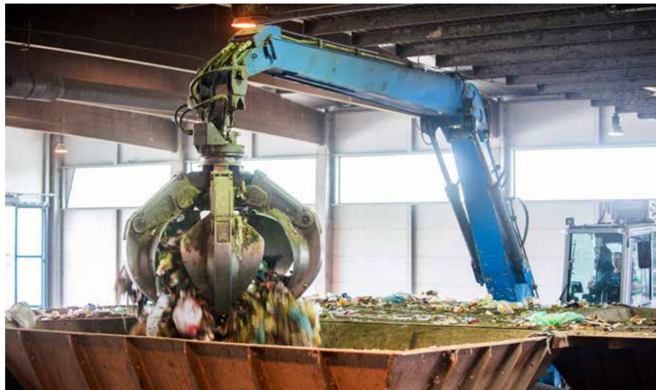
Eine optimale Verwertung des Restabfalls durch mechanisch-biologische Behandlung kommt dem Klima zugute.
