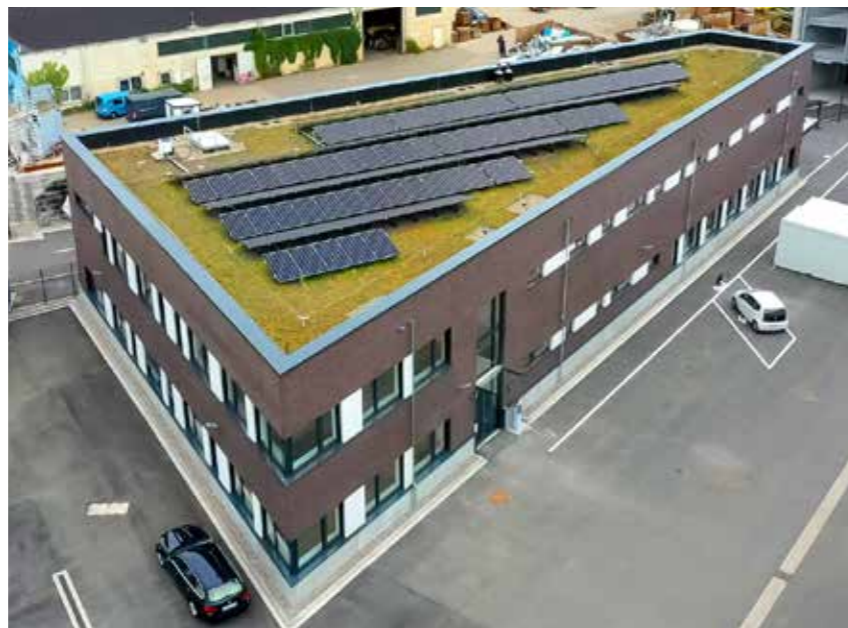
Klimaschutz dank moderner Gebäudetechnik: Passivhausstandard auf der Betriebsstätte der Stadtreinigung in der Gertrud-Knebusch-Straße.
